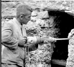
**Bosch – elektrischer Bohrhämmer**
