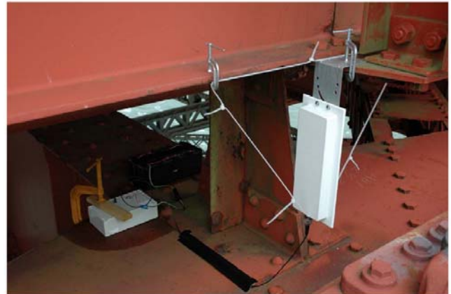
Abbildung 7: Installiertes Sensor Board, Antenne und Batterie [4]
